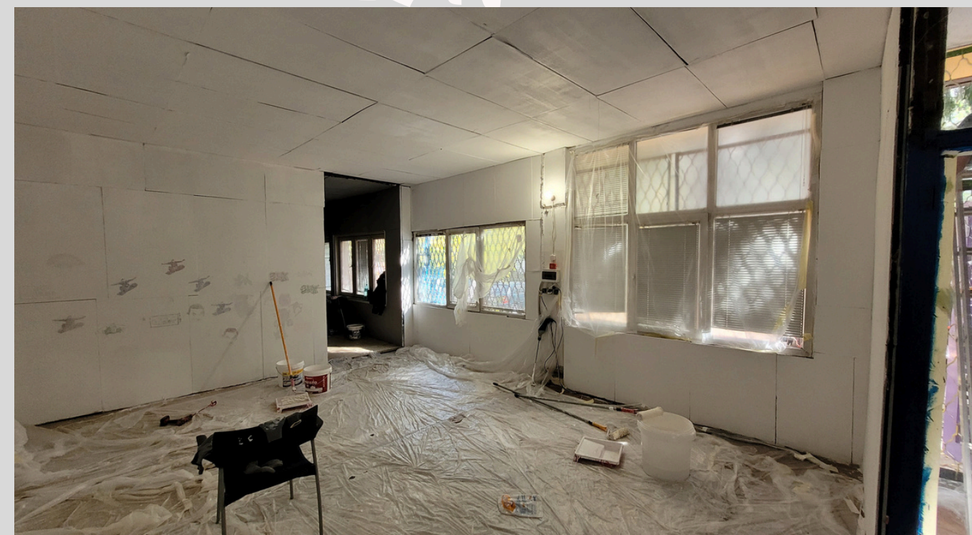
Ремонт на новата сграда читалището
